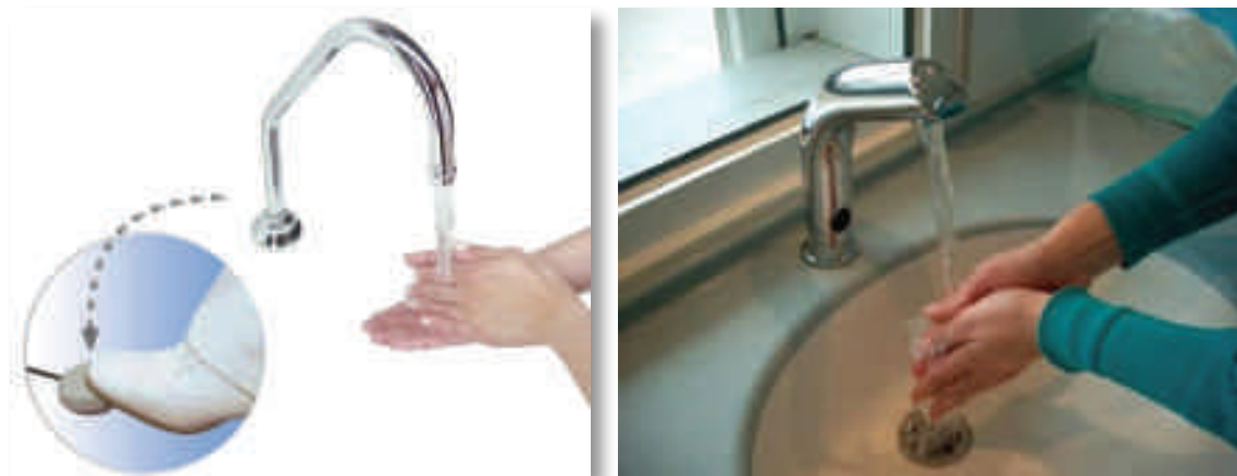
Figura 56 - Torneiras acionadas por pedal ou por sensores de aproximação.
