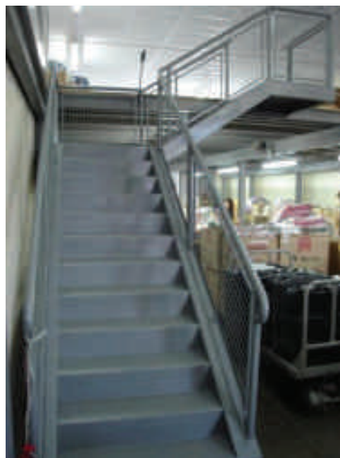
Figura 38 - Escadas com proteções laterais e tapadas na frente e parte lateral dos degraus.
